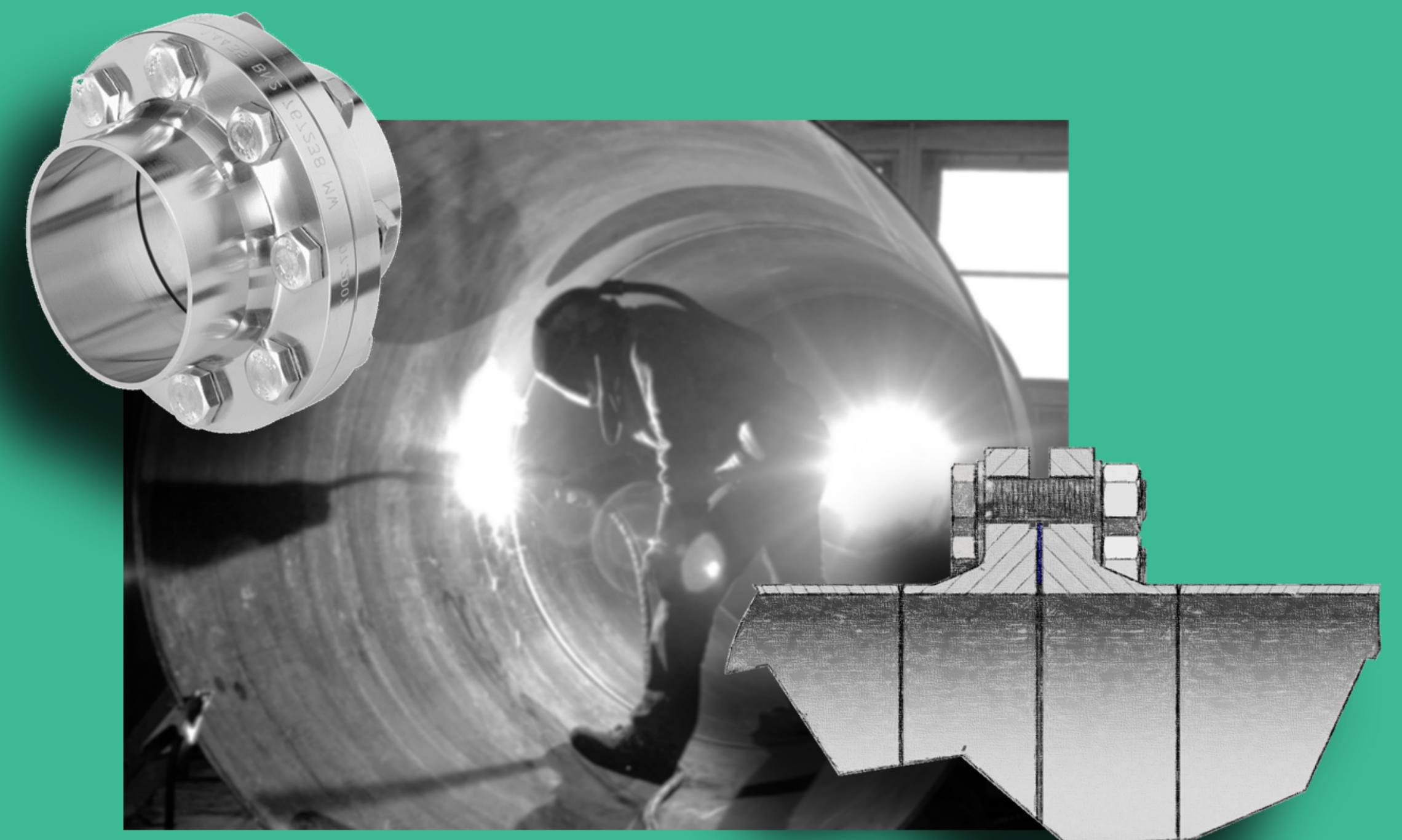
Abbildung 1: Schweißen einer Rohrleitung
