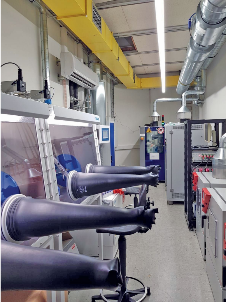
Abb. 3: Das 2019 in Betrieb genommene Batterielabor Enerlab 4.0; Bild: Mehmet Yagci, HSO
