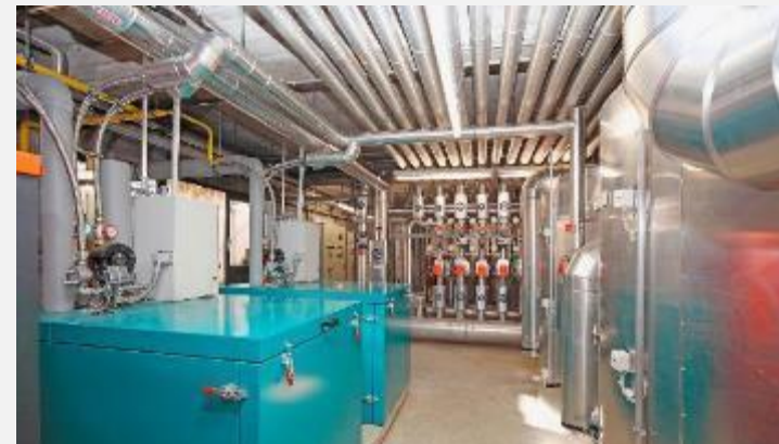
Wartungsoptimierung »BHKW-Flotte enerquinn«
